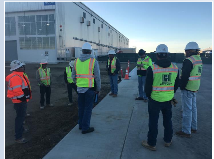
Prepping to pour concrete at AFRC
